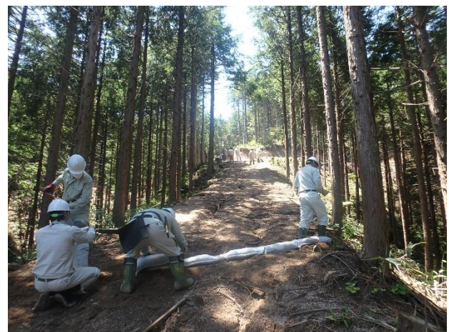
路面洗堀の進行を防ぐ横断溝の設置
